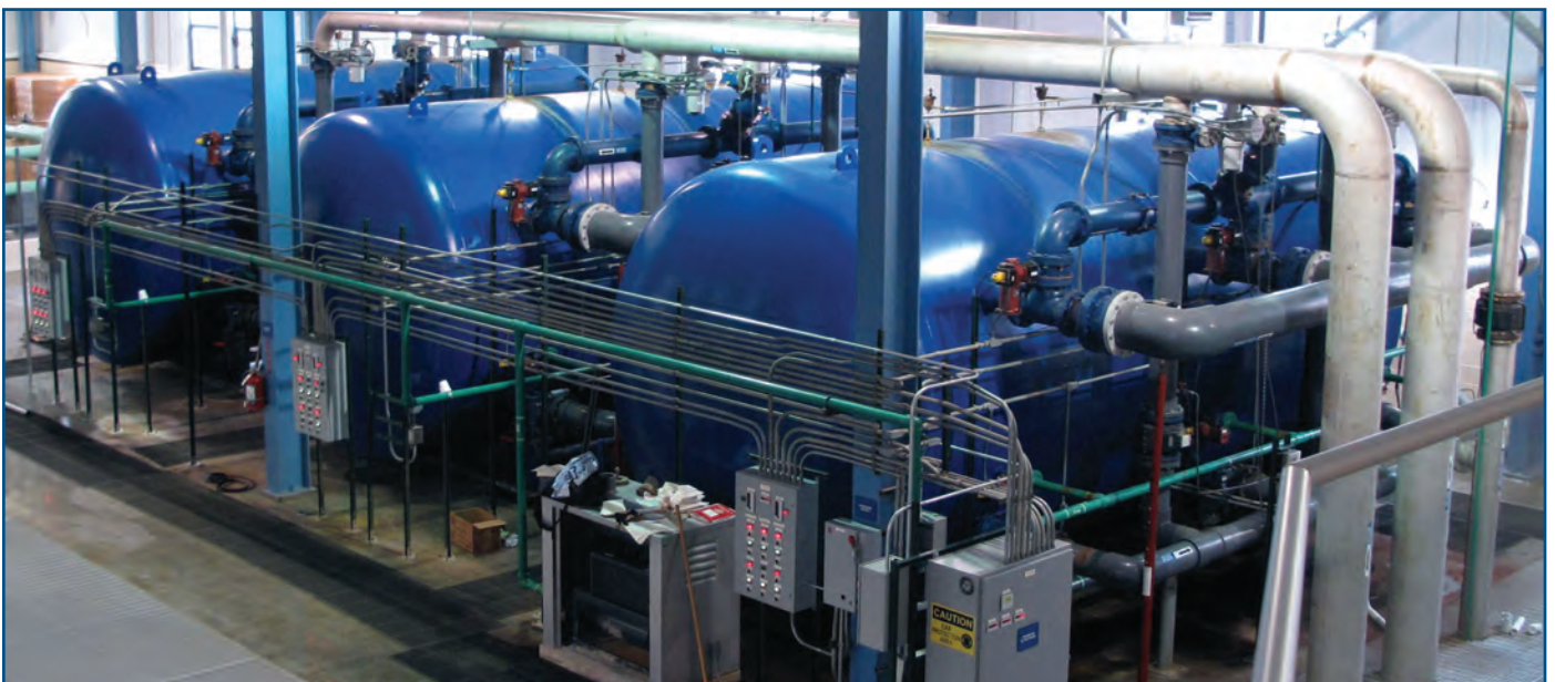
Pretratamiento GreensandPlus para el sistema de filtrado de ósmosis inversa de 4.2 MGD
